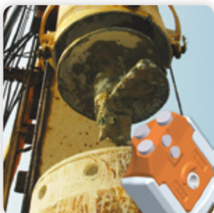
5 - Специальное подземное строительство
