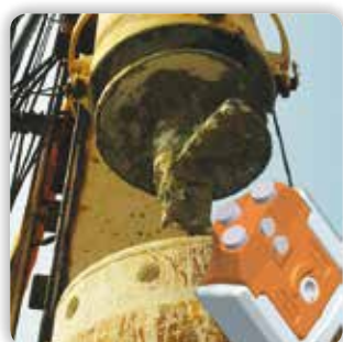
5 - Специальное подземное строительство
