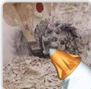
11 - Экскаваторное фрезерование
