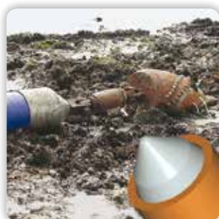
7 - Горизонтальное бурение (наклонно-направленное бурение)
