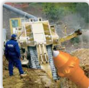
9 - Фрезерование траншей
