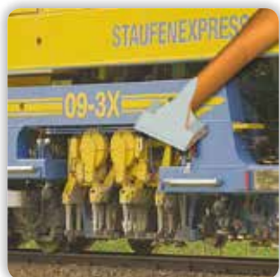
14 - Укладка рельсовых путей
